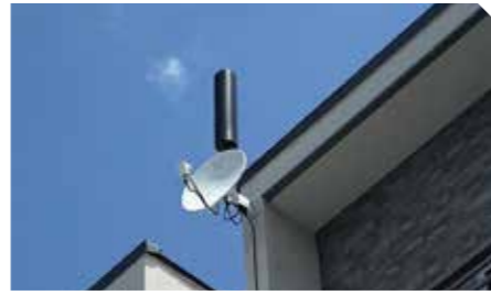
P03.04 アンテナ工事
